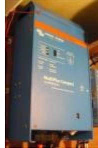
Der Wandler wechselt automatisch zur zugeführten Energiequelle.
